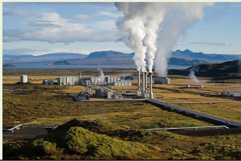
La Central Geotérmica de Nesjavellir. Prácticamente, toda la electricidad de Islandia proviene de fuentes de energía renovable.
